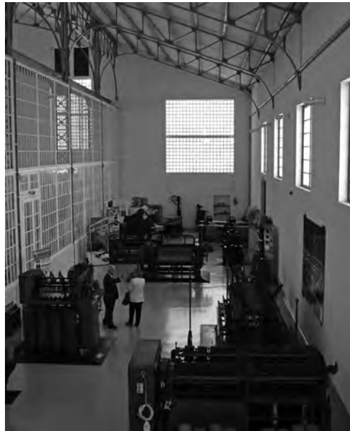
Fig. 7 – Vista interior após as obras de reutilização do espaço para Museu – Núcleo da Juta
