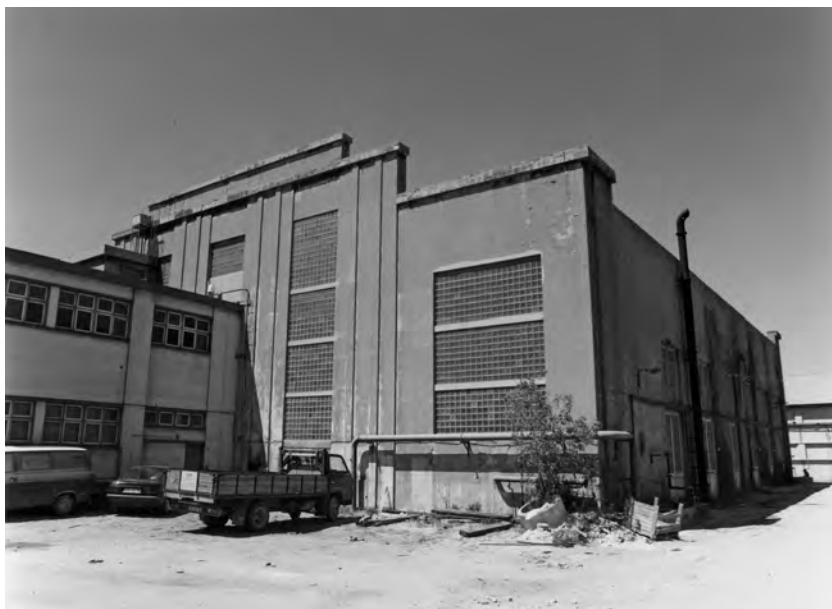
Fig. 8 – Vista parcial do edifício da antiga Central Diesel, antes da intervenção
