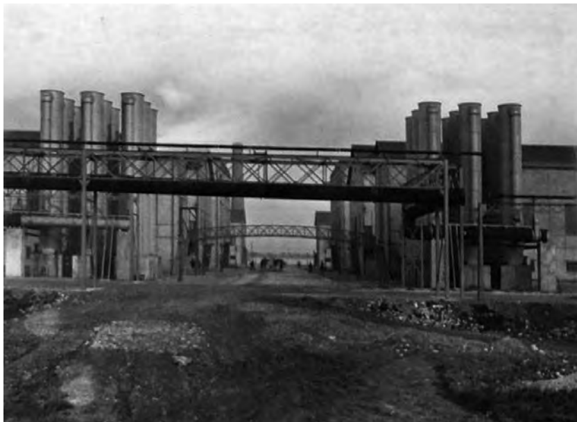
Fig. 4. Um sector do «anel de gás de Paris»: instalações de purificação do gás em Gennevilliers (do álbum da construção)
