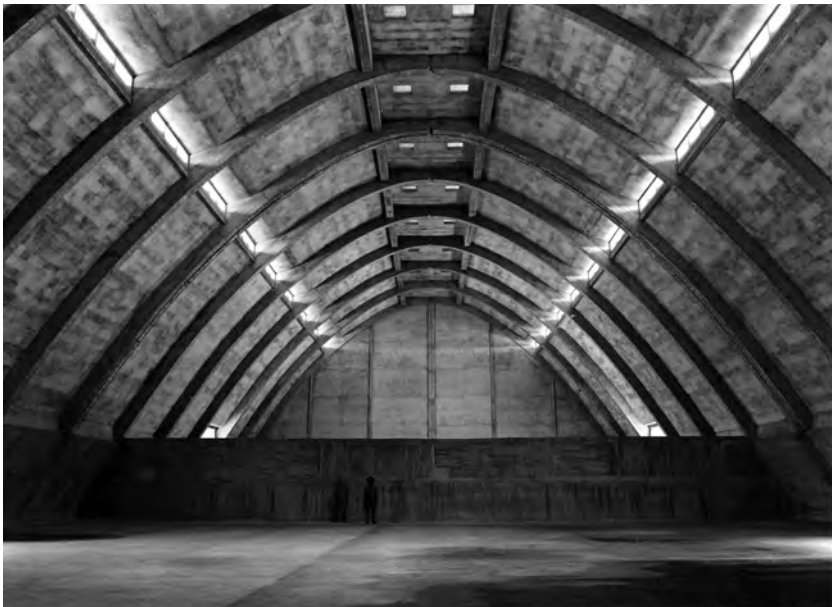
Fig. 4 – Silo de enxofre. Centro de projectos da CUF. 1960 Arquivo CUF, Alverca
