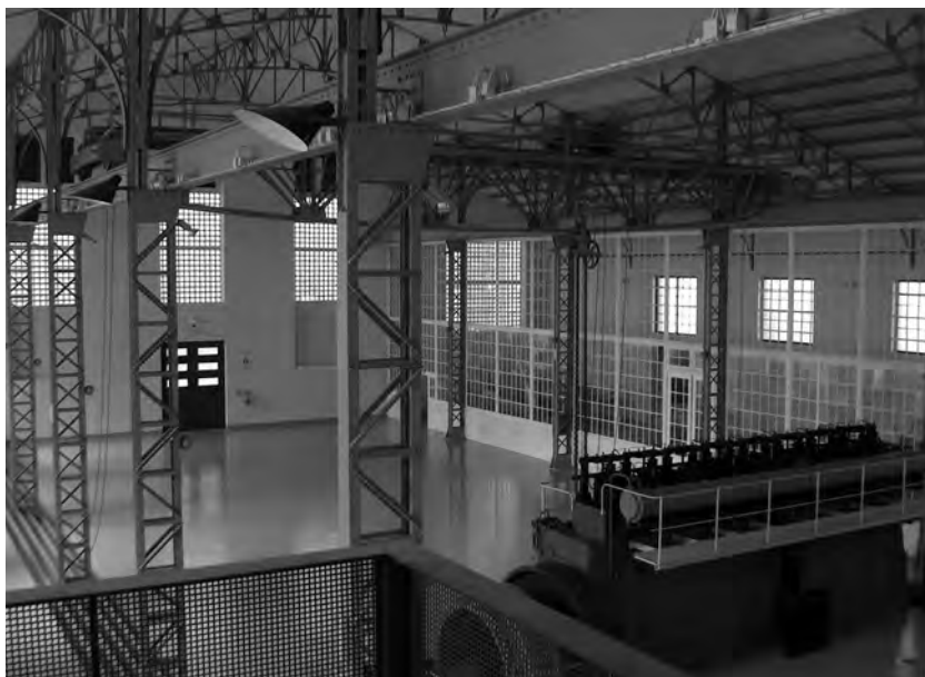
Fig. 5 – Vista do interior da nave após as obras de restauro e conservação
